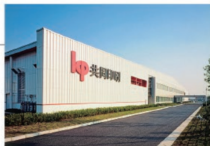
共同印刷メディアプロダクト 五霞工場
